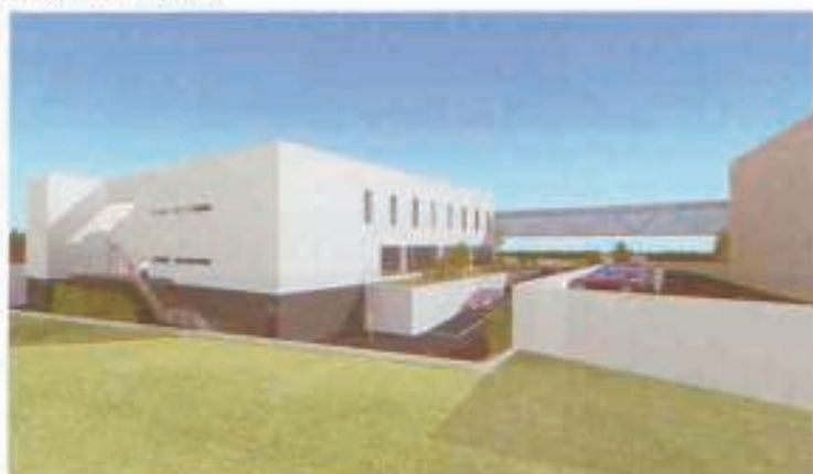
Passadizo de ligação entre os dois edifícios
