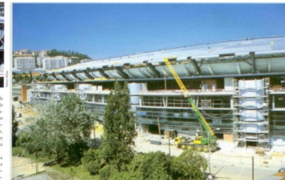
adas dominante com painéis de vidro sem caixilharia, com painéis de alumínio tipo sanduíche para encerramento dos corpos semicirculares das escadas. As frentes comerciais serão protegidas por uma grelha de palas metálicas, no piso térreo, e por elementos que escondem o interior das lojas e criam área de montra, no piso superior.
