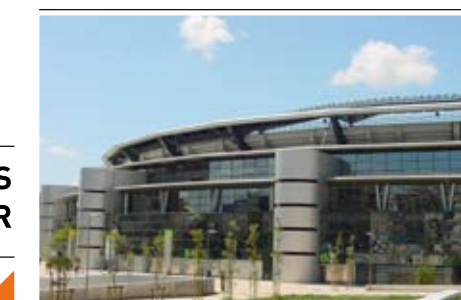
Estádio Cidade de Coimbra | Coimbra
