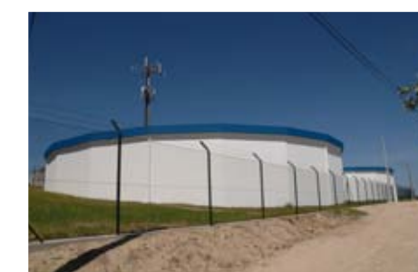
Reservatório de Água da Fazaga | Fátima
