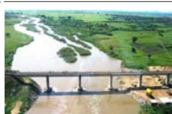
Ponte Ferroviária Rio Cubal
