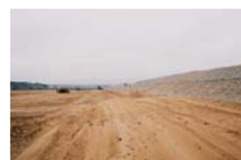
Desassoreamento Rio Bero | Namibe
