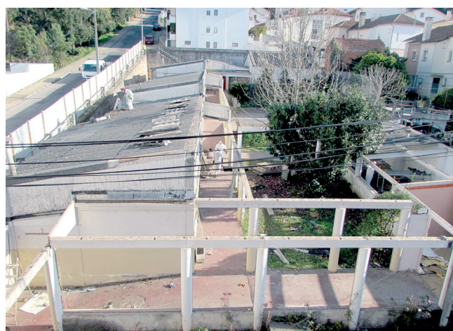
As obras do novo colégio já estão a decorrer
